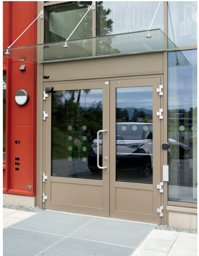
Hovedinngang med beskyttelse mot nedbør.
